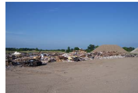
Demolition Landfill Site
